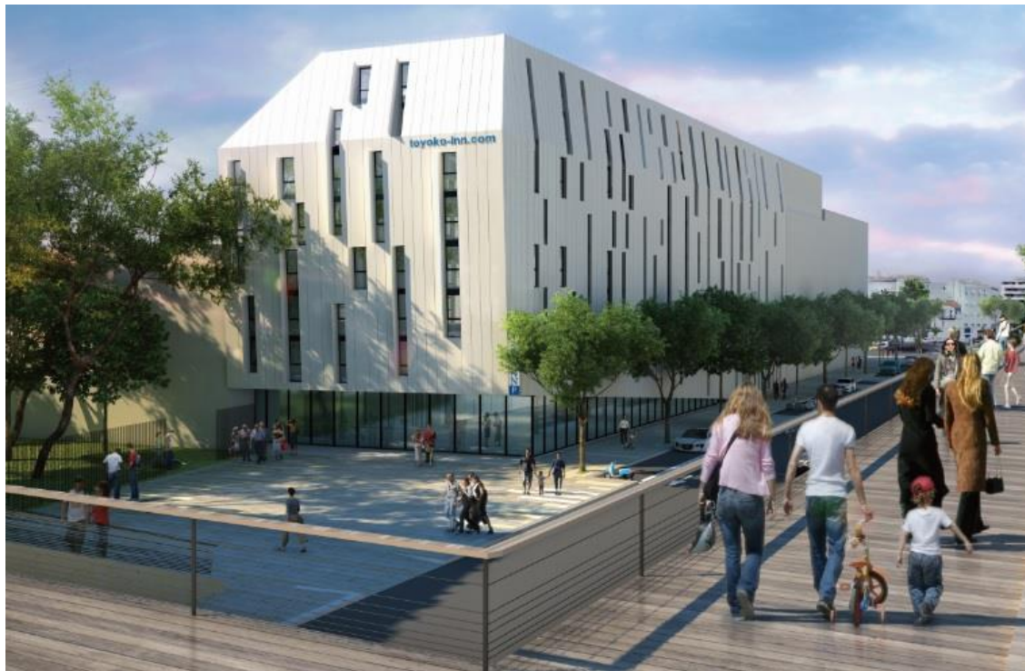
東横 INN マルセイユ サン シャルル駅前 (8階建・267室)
